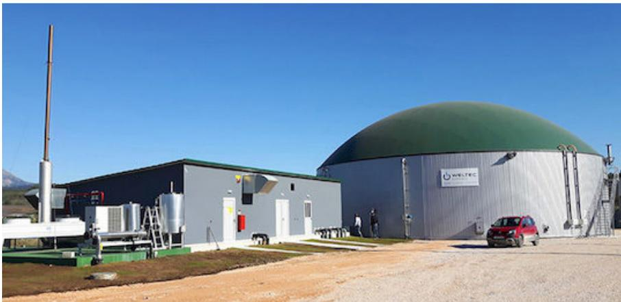
Figure 8 Digesteur anaérobie pour la fermentation du fumier en compost et en biogaz
